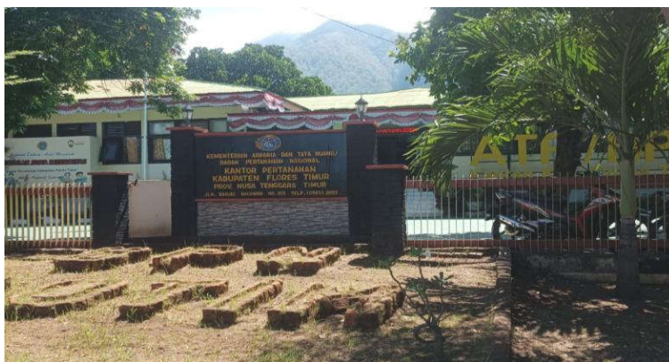
Gedung BPN Kabupaten Flores Timur
